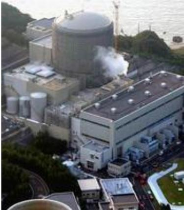
核能发电 英文：nuclear electric power generation 利用核反应堆中核裂变所释放出的热能进行发电的方式。它与火力发电极其相似。只是以核反应堆及蒸汽发生器来代替火力发电的锅炉，以核裂变能代替矿物燃料的化学能。除沸水堆外（见轻水堆），其他类型的动力堆都是一回路的冷却剂通过堆心加热，在蒸汽发生器中将热量传给二回路或三回路的水，然后形成蒸汽推动汽轮发电机。沸水堆则是一回路的冷却剂通过堆心加热变成70个大气压左右的饱和蒸汽，经汽水分离并干燥后直接推动汽轮发电机。
