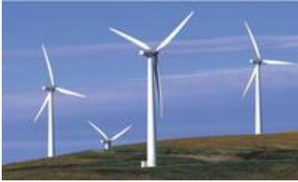
风力发电机是将风能转换为机械功的动力机械，又称风车。广义地说，它是一种以太阳为热源，以大气为工作介质的热能利用发动机。
