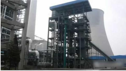
国电长源10MWe级生物质气化耦合发电
