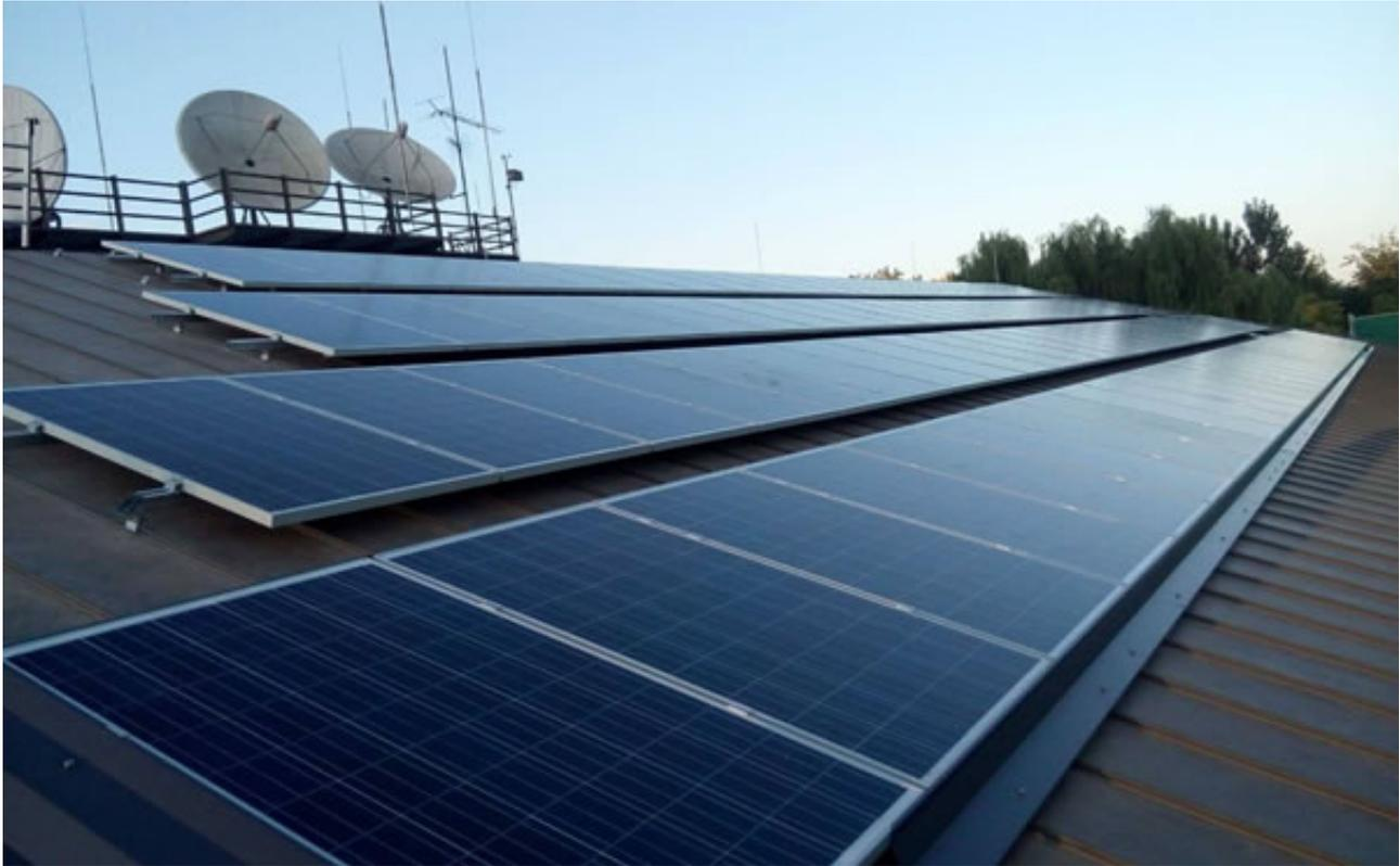
天能集团锂电三期厂房屋顶分布式光伏发电及智能微网铅炭储能项目位于天能集团总部厂区内，在锂电车间屋顶搭建太阳能光伏电站，设计一期装机容量为1.65MWp，由天能集团投资，国内知名的光伏电力工程承包商晶科电力公司负责承建，按照国内先进的组阵方案，将光伏电池组件安装于车间水泥屋顶之上。
