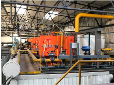
◆ 太原小渣热电厂116MW锅炉燃烧器 ◆
