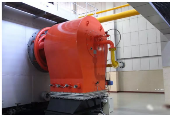
◆ 北京仁和5台58MW热水锅炉配套燃烧器 ◆
