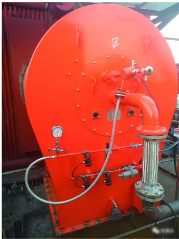
◆ 山西中捷源2台58MW锅炉燃烧器 ◆
