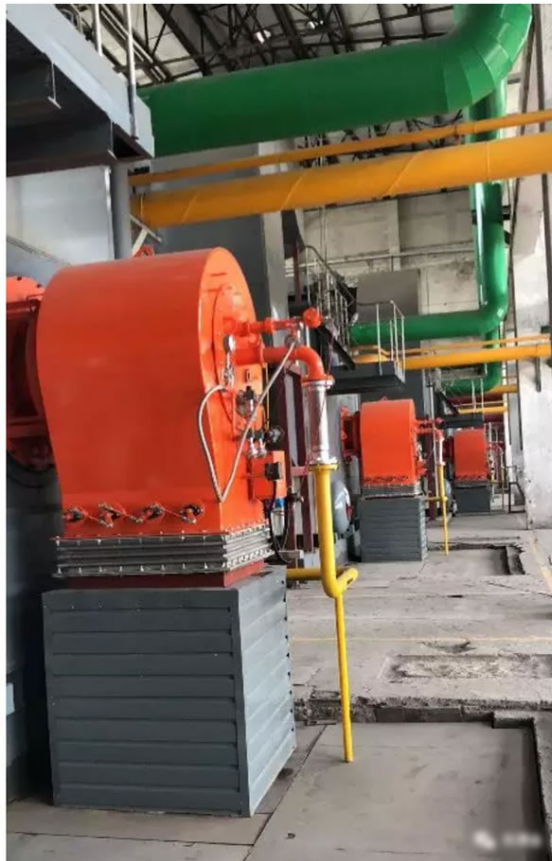
◆ 北京天利热力3台29MW热水锅炉项目 ◆
