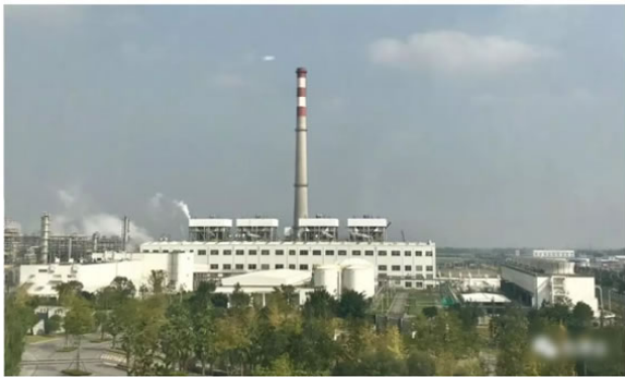
◆ 四川石化420吨锅炉改造项目 ◆
