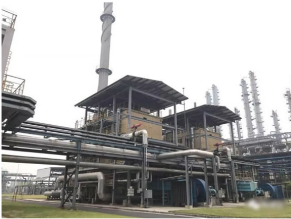
◆ 中海油惠州炼化3台220吨蒸汽锅炉配套燃烧器项目 ◆
