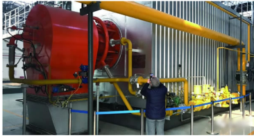
◆ 北京奕创2台58MW锅炉燃烧器 ◆
