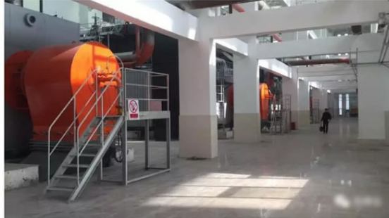
◆ 北感通州4台70MW热水锅炉项目 ◆
