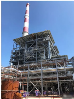
◆ 金陵石化南京罗茨切丙烷脱氢项目 3台100吨锅炉燃烧器
