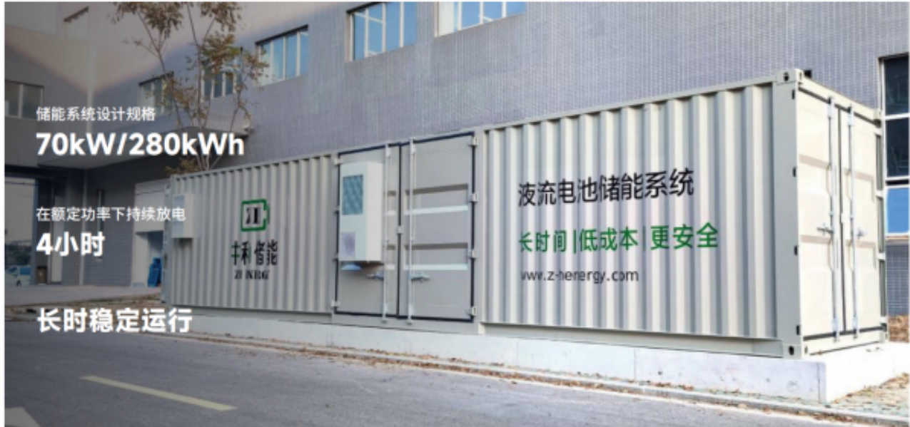
某地光储充一体化项目中的储能模块
