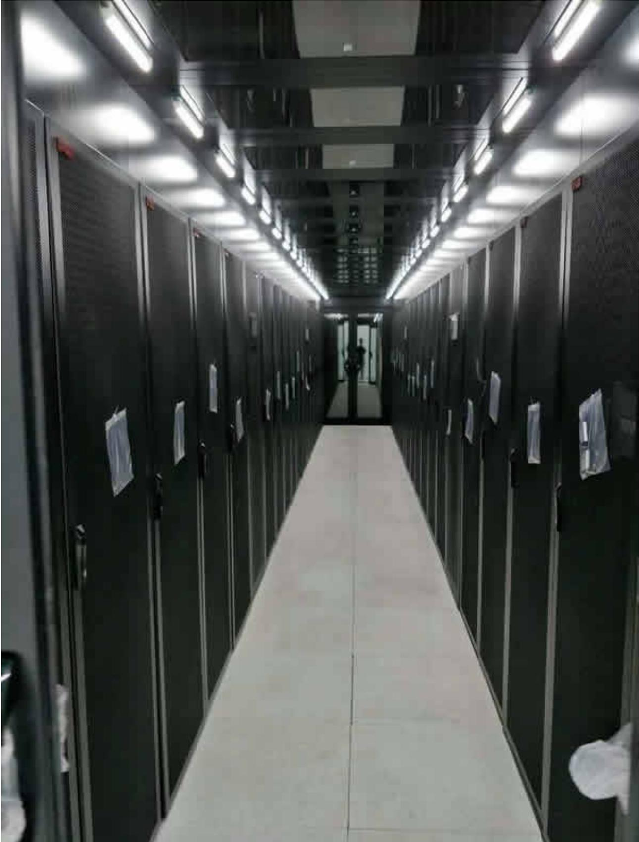
此次蒙东云计算数据中心机房建设，采用了易事特MC6000系列微模块为主体，集成200多台E系列服务器机柜、30余台高效节能行级精密空调、以及多台模块化EA66400系列大功率UPS等数据中心系统产品，并在常规模块化数据中心系统产品基础上新增智能管理等电子系统，如：微电脑数控自动门（遥控开关/声光控制/安全光线）、智能温感、消防联动、后续自动翻转天窗系统等。同时在微模块建模安装周期上售后服务突破了以一天一套的快速建模时长，有
