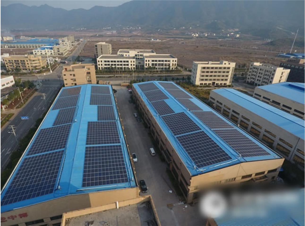
浙江丽水经济开发区30MWp（一期10MWp）分布式光伏发电项目，是丽水市迄今为止建成的规模最大的屋顶分布式光伏项目，分别在7个企业屋顶建设。该项目的投运，既为企业带来很可观的经济效益，也为社会带来了良好的环保效益。据测算，该项目首年发电约1022万度，与发电能力相同的火电厂相比，可节约标煤约3678吨，减排二氧化碳约10187吨、二氧化硫约306吨、氮氧化物约153吨、粉尘约2779吨。
