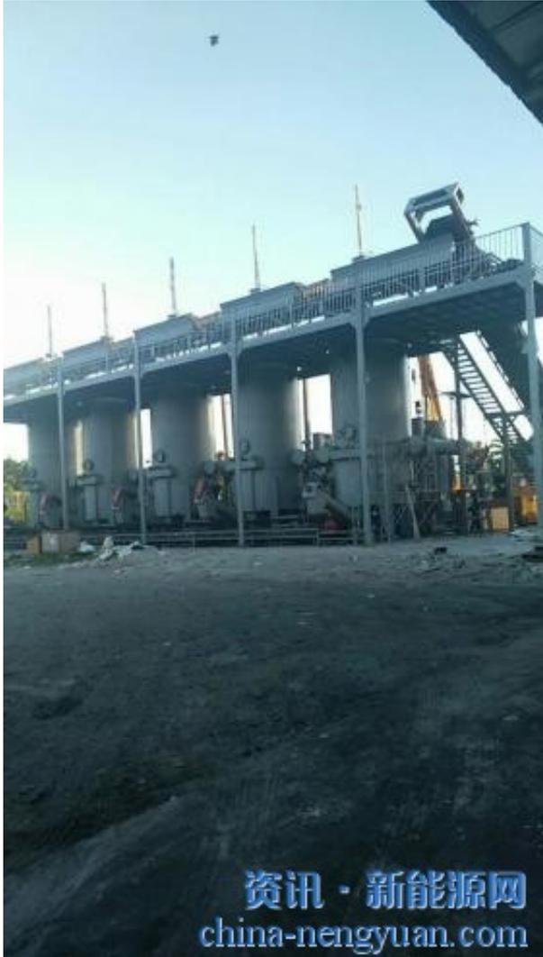
近期，海琦新能源为马来西亚某上市公司设计生产的应用工业垃圾为燃料，以五台海琦气化系统联产供应28吨蒸汽锅炉发电项目正在如火如荼地进行现场安装阶段。
