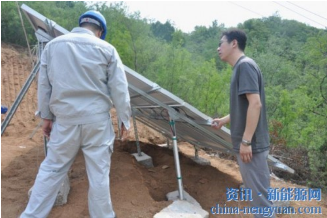
图为审计人员在光伏发电项目施工现场。
