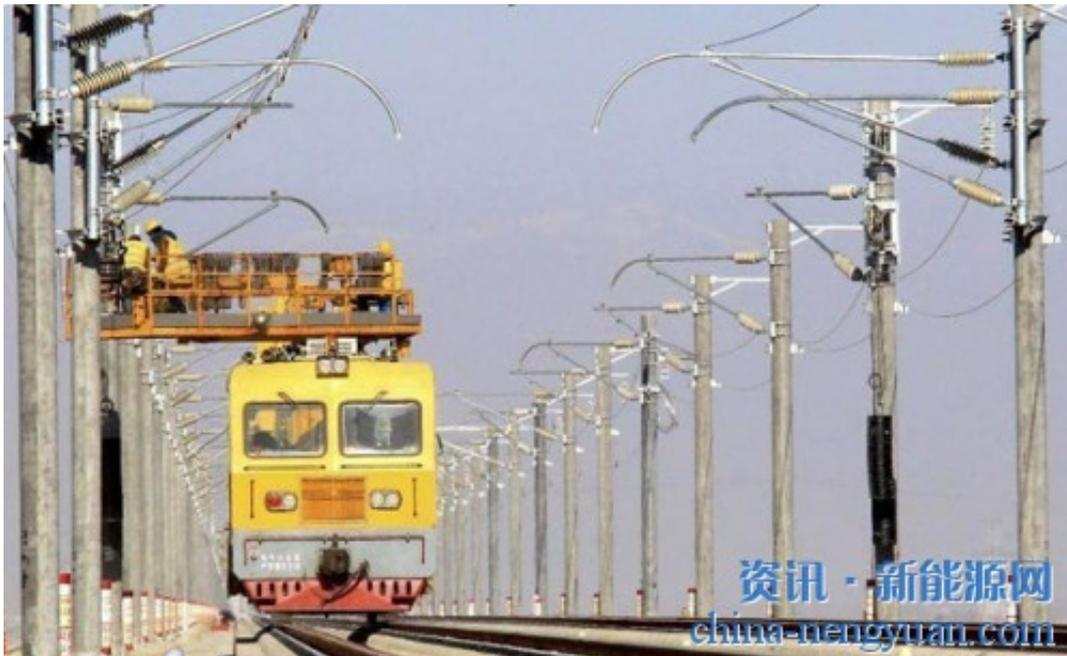
在“兰新高铁”新疆哈密盐泉段，建设者在电气化工程车上安装接触网电缆。（资料图）
