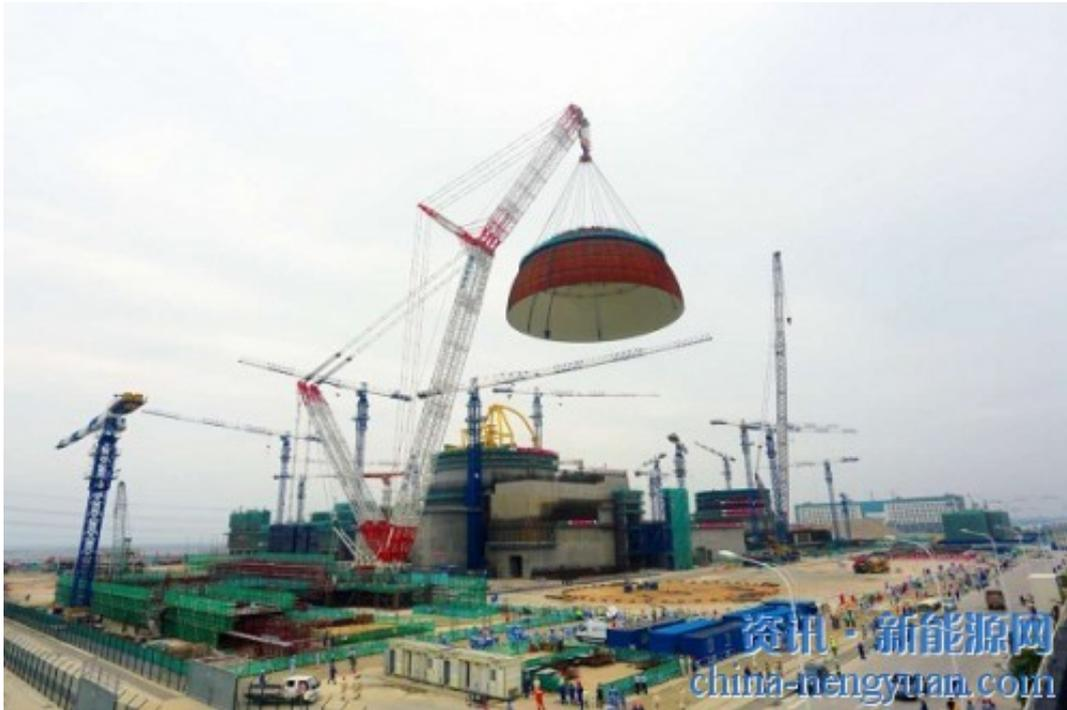
2017年5月25日17时58分，中国核建承建的“华龙一号”全球首堆示范工程福清核电5号机组顺利实现穹顶吊装。
