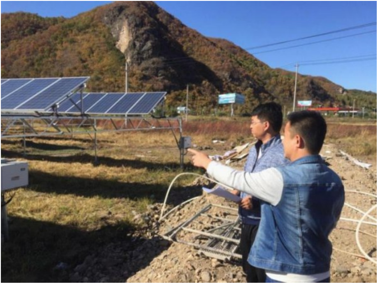
图为审计人员实地勘查光伏发电项目现场。
