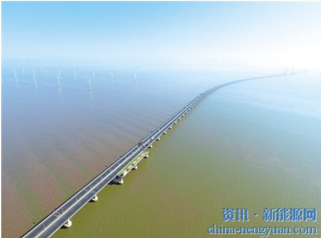
图为俯瞰上海东海大桥海上风电场。新华社记者 丁汀摄
