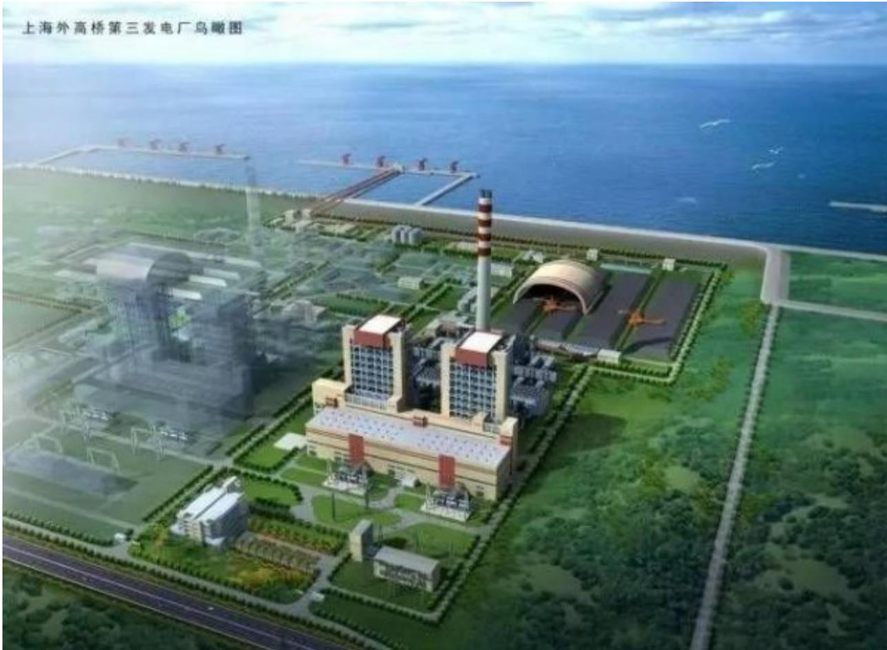
该厂当前的实际运行性能，在全年平均负荷率为75%~81%的条件下，其实际全年平均供电煤耗(包括脱硫和脱硝)276gce/kWh，折算到额定负荷下的供电煤耗为264gce/kWh，全年平均实际供电效率(包括脱硫和脱硝)为44.5%，折算至额定负荷工况，则供电效率应为46.5%。而2015年全国发电平均煤耗318gce/kWh。排放浓度:粉尘排放7.55mg/m<sup>3</sup>；二氧化硫17.7mg/m<sup>3</sup>；氮氧化物15.19mg/m<sup>3</sup>，已经达到了气体燃料的排放指标。
