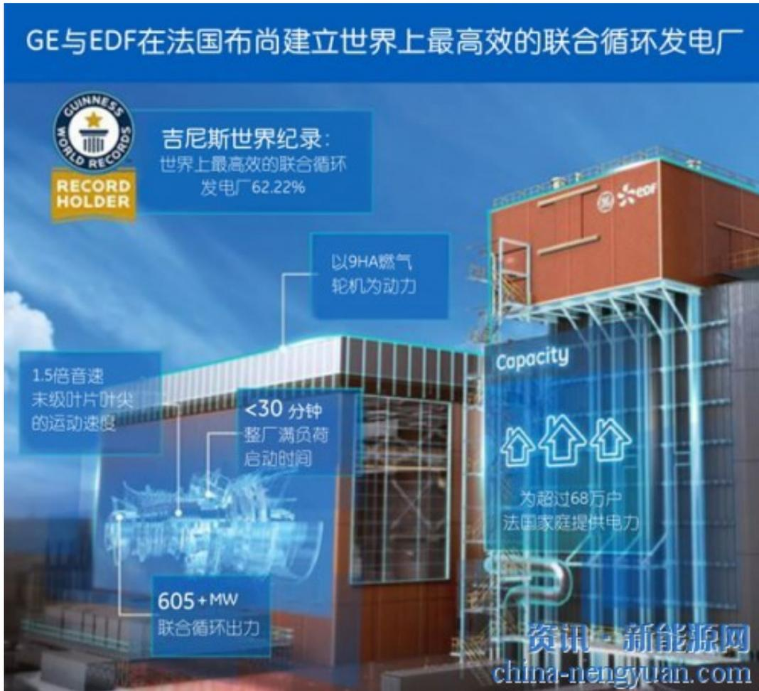
在法国北部一个叫布尚的小镇刚刚爆出了一项吉尼斯世界纪录：全球最高效的联合循环发电厂诞生了。这家电厂跳动的“心脏”就是一台GE研发的9HA重型燃气轮机，它可以将62.22%的燃料能量转化为电能，这无疑是发电行业的神圣数值，为所有发电方式之冠。经运行验证，应用于布尚电厂的9HA燃气轮机联合循环出力达605兆瓦，是全球最高效的燃气轮机。
