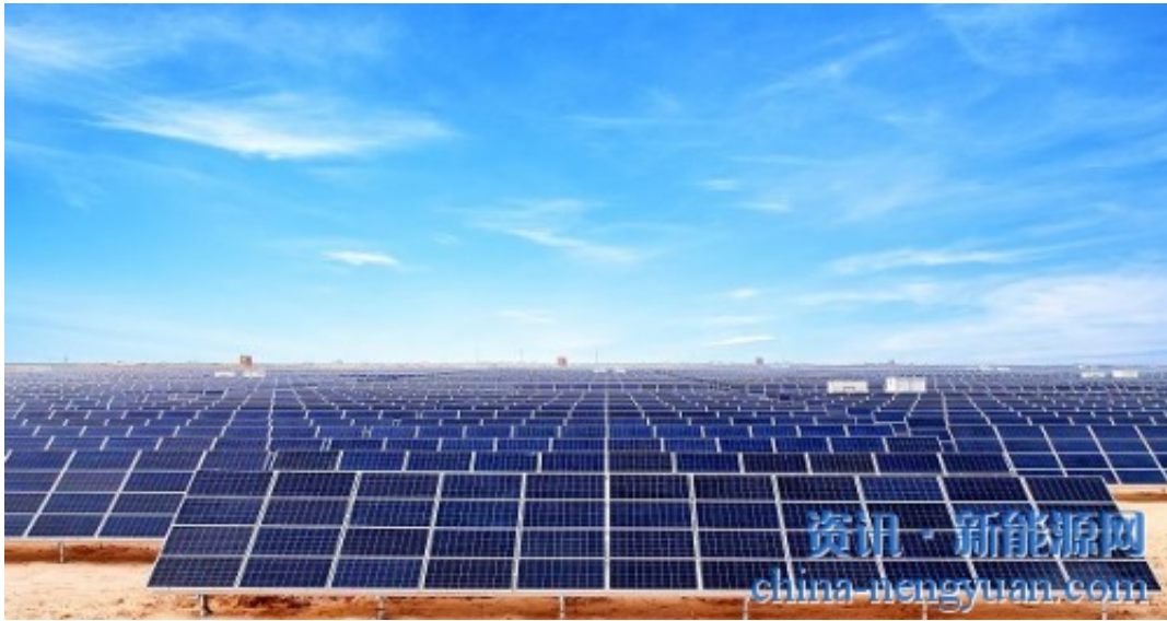
中国电建承建的阿尔及利亚233光伏电站项目巴特纳站。
