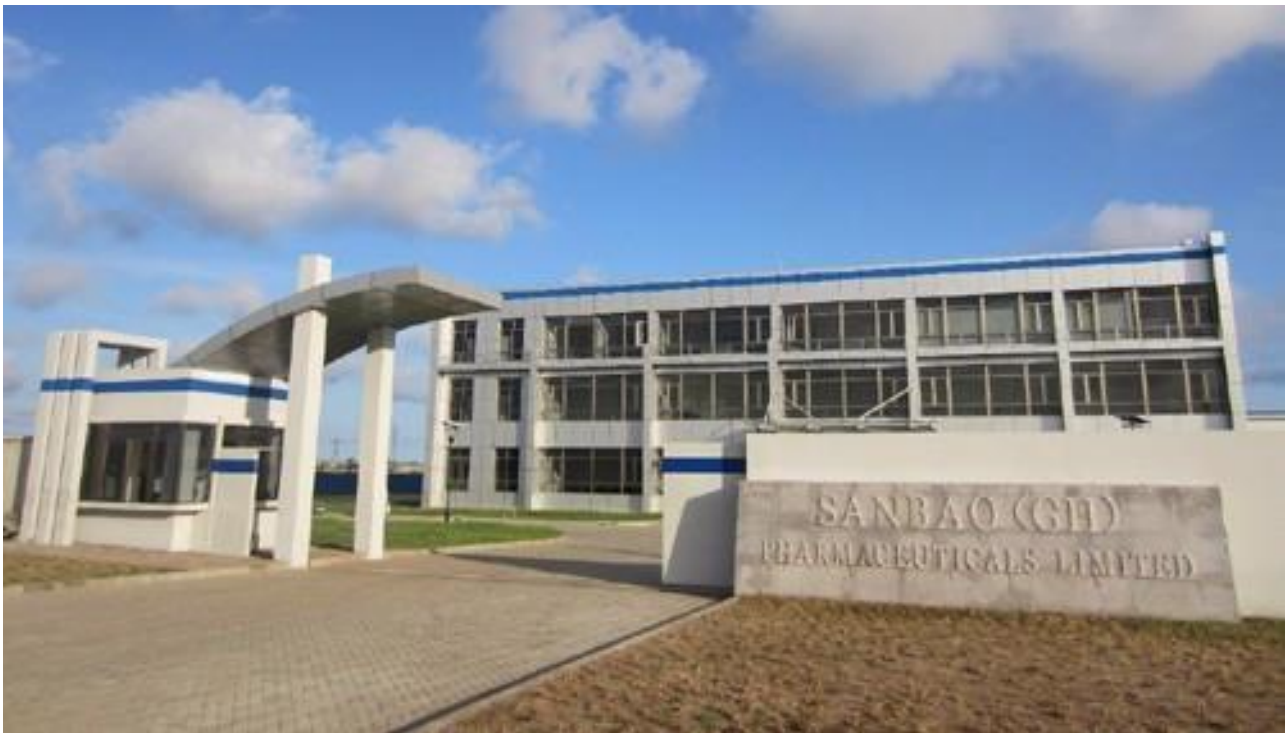
晨阳水漆涂刷工程——加纳三宝药厂
