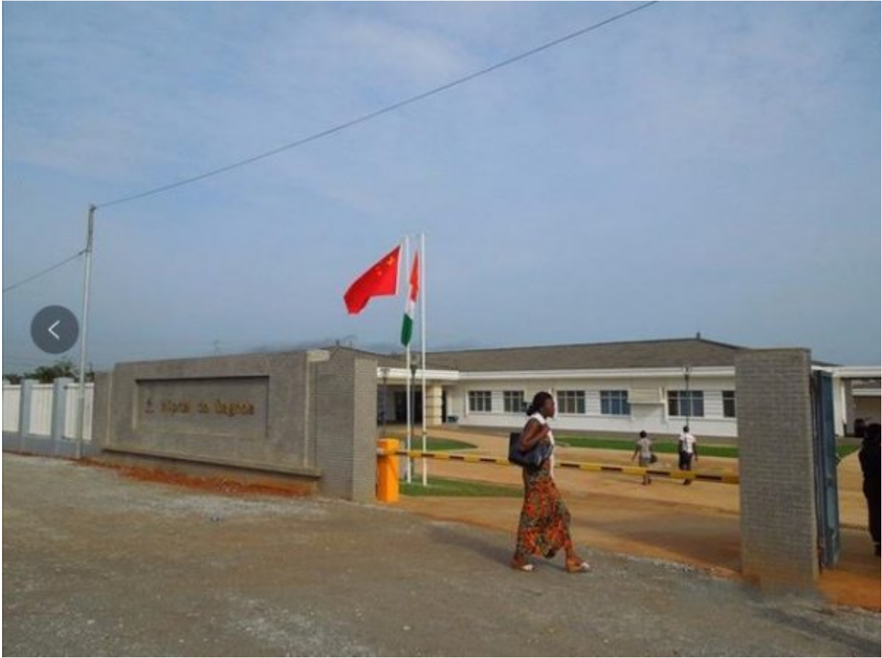
晨阳水漆涂刷工程——科特迪瓦医院
