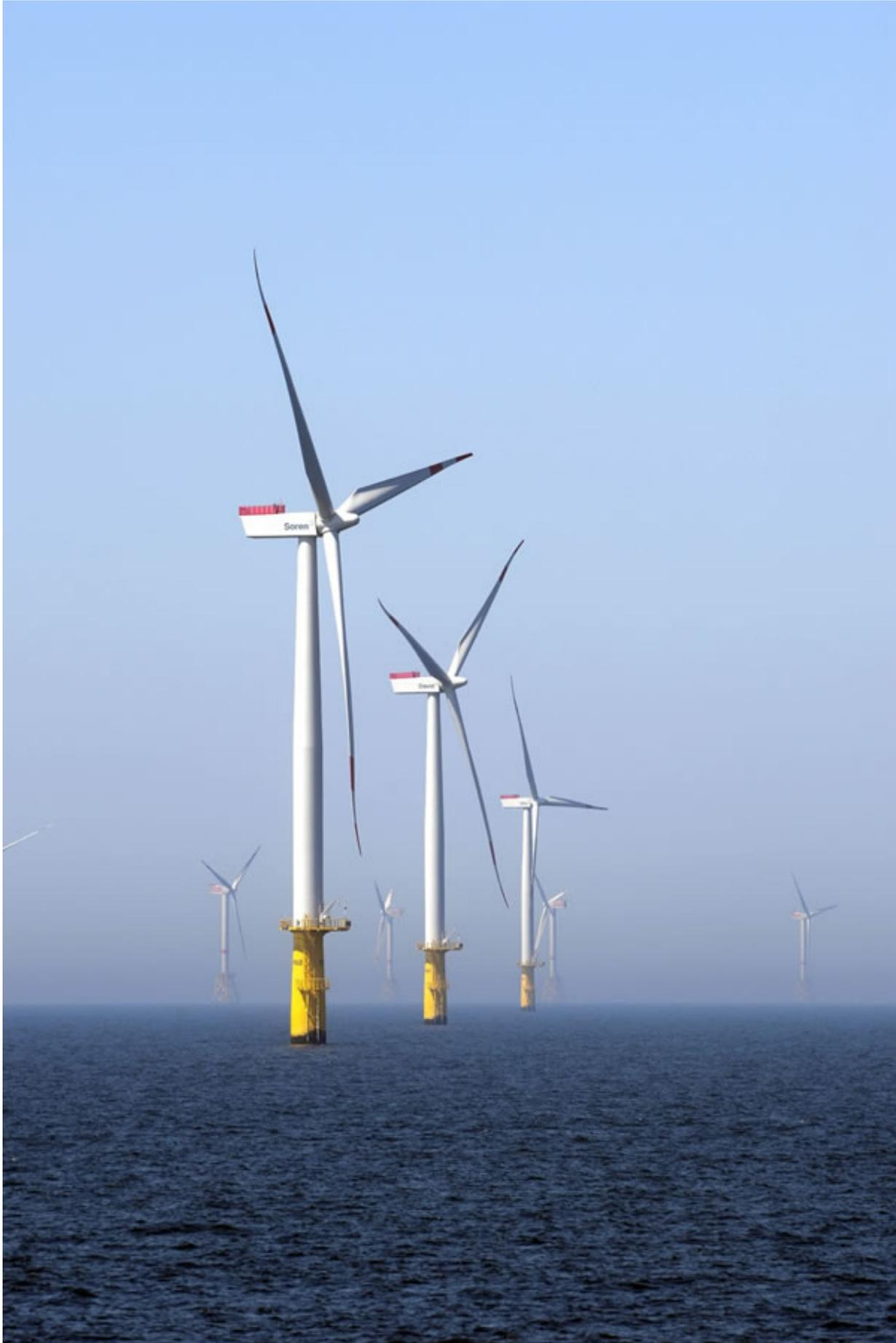
在设计阶段，德国海上风电还注重防腐，确保基座不会对环境造成不利影响。这是因为在海上风电基础结构中，海水中的钢结构占很大比重，而钢结构在海水中易发生腐蚀，因此采用ICCP系统（阴极保护技术）十分必要。严思介绍，该系统是电化学保护技术的一种，其原理是向被腐蚀金属结构物表面施加一个外加电流，被保护结构物成为阴极，从而使得金属腐蚀发生的电子迁移得到抑制，避免或减弱腐蚀的发生，加强对基座的保护。
