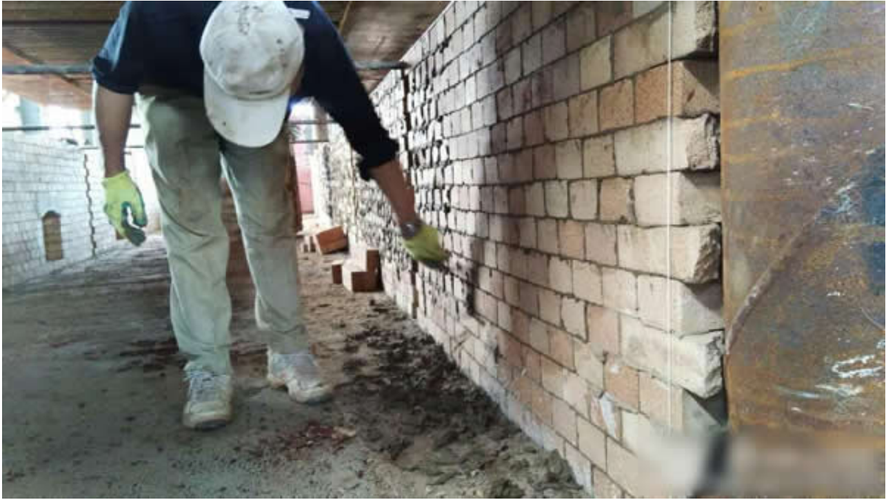
热风炉的精心砌筑中
