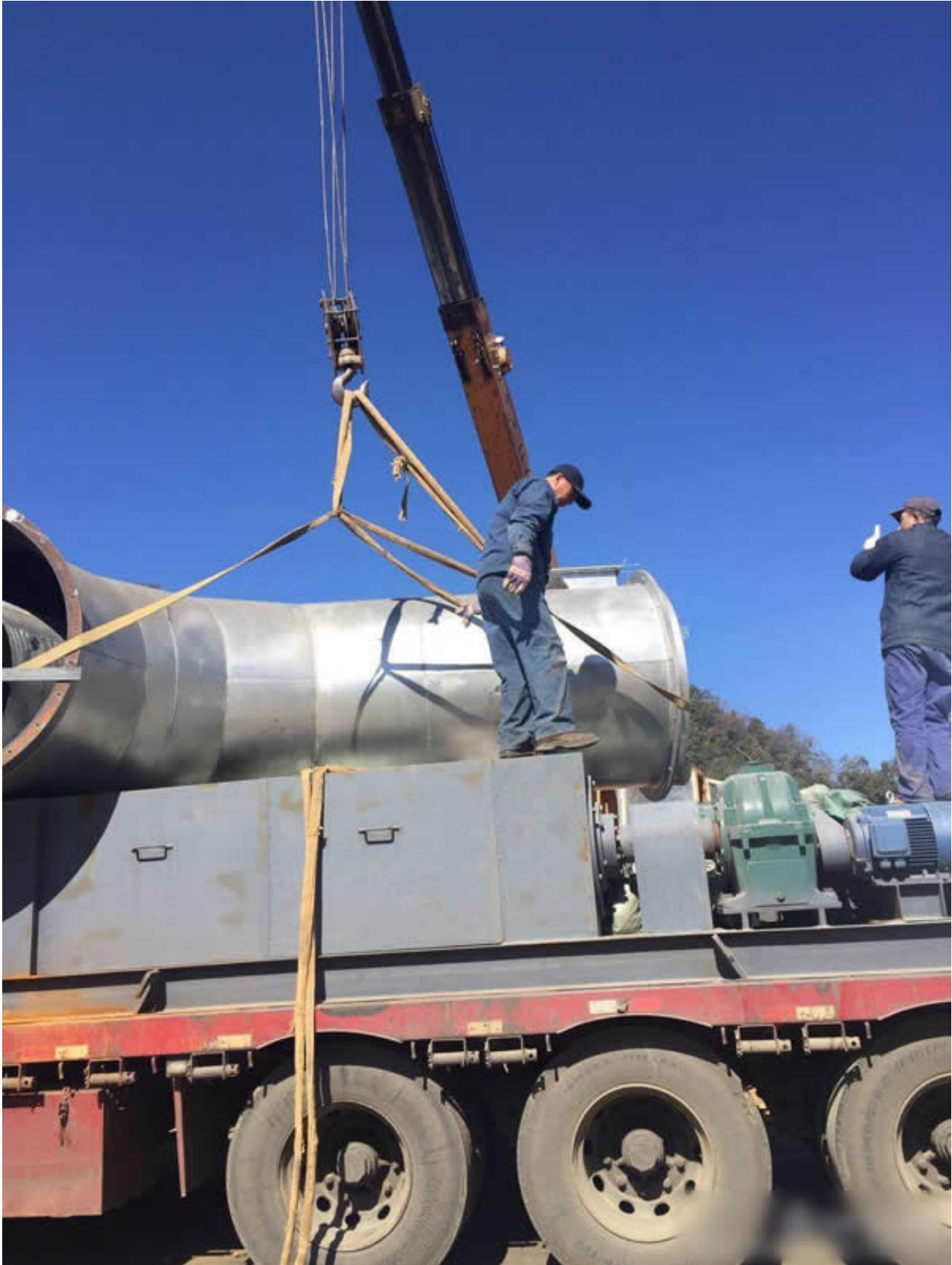
大型烘干设备的安装之中（在印度）
