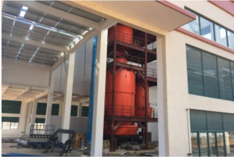
4、10吨气化炉，应用于10吨蒸汽锅炉
