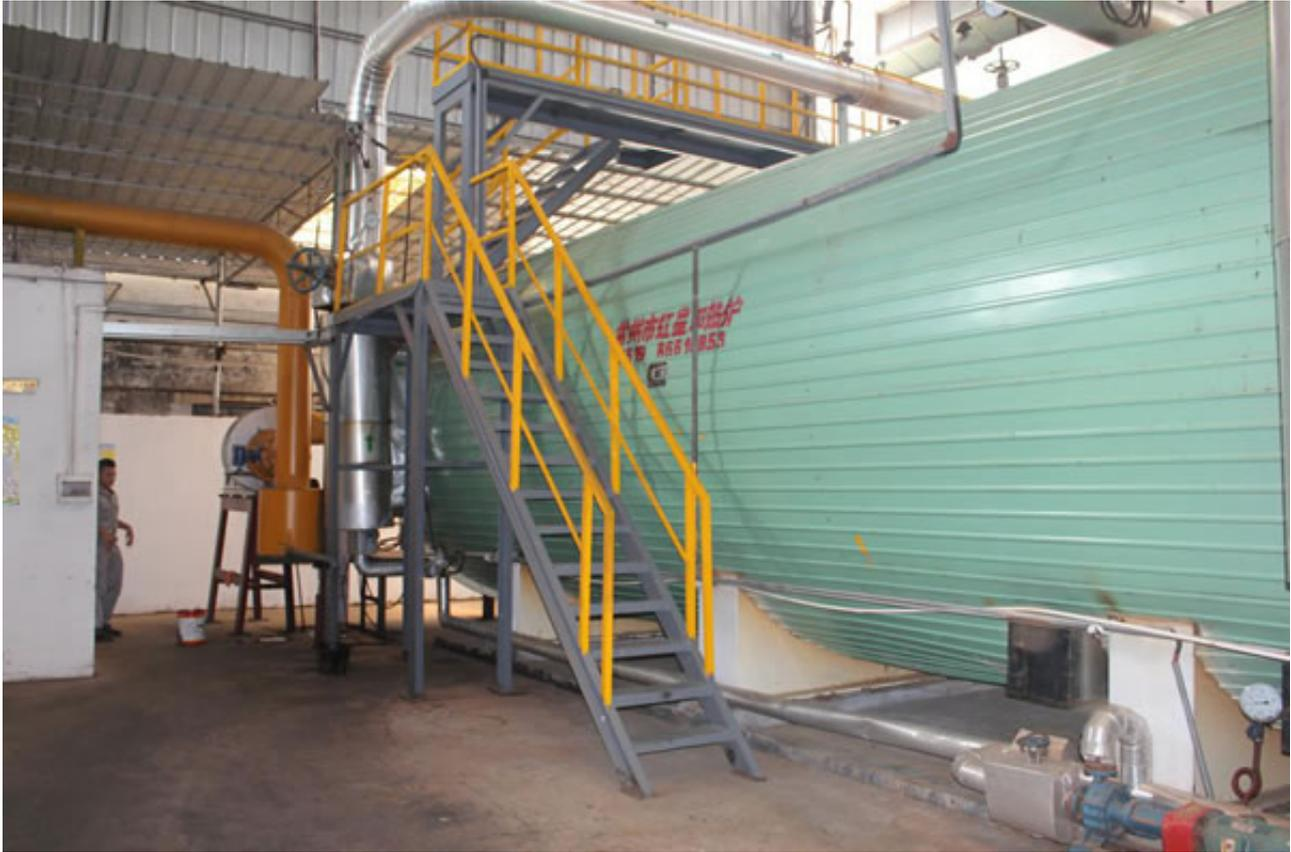
6、12吨气化炉用于12吨蒸汽锅炉
