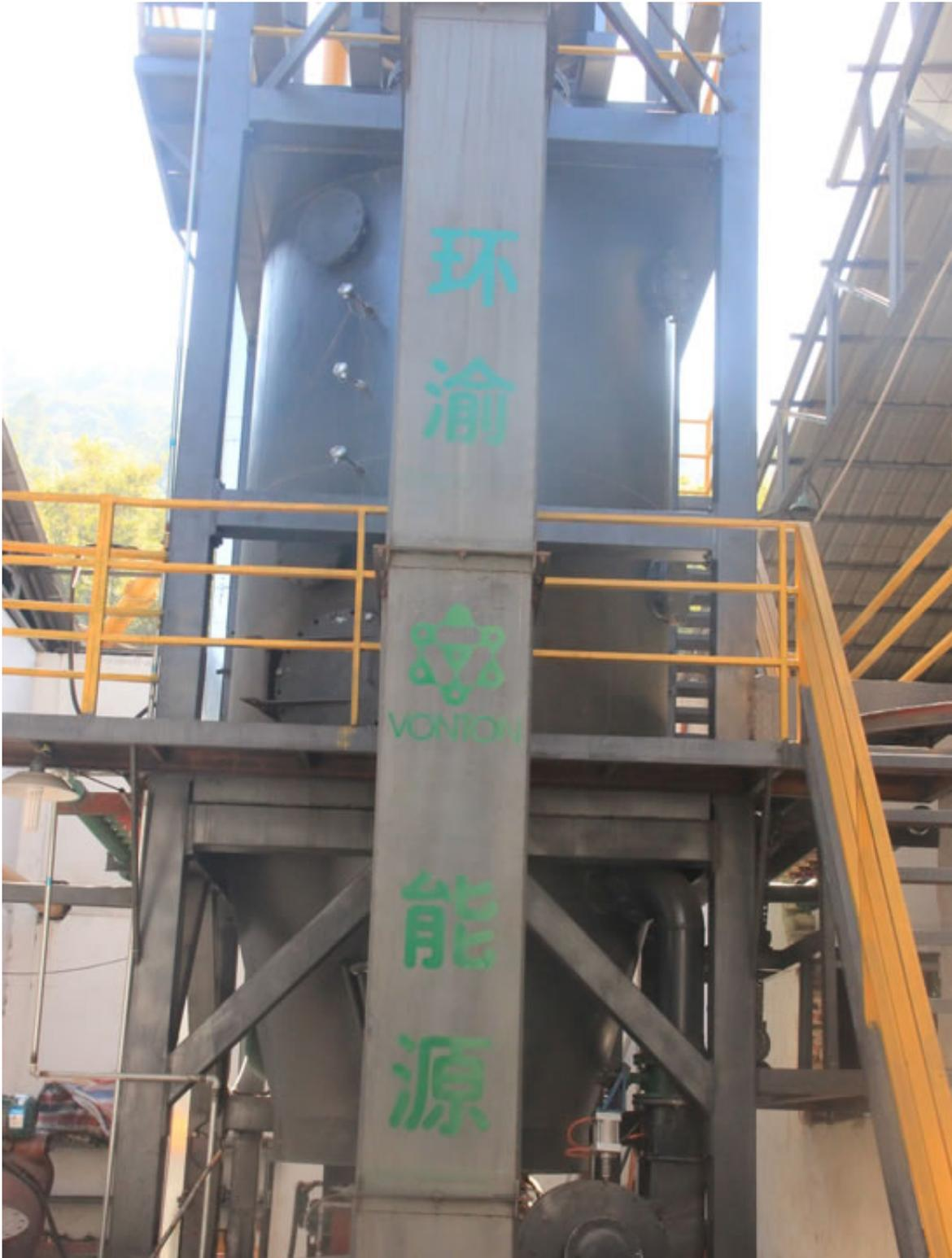
2、6吨气化炉，应用于6吨蒸汽锅炉
