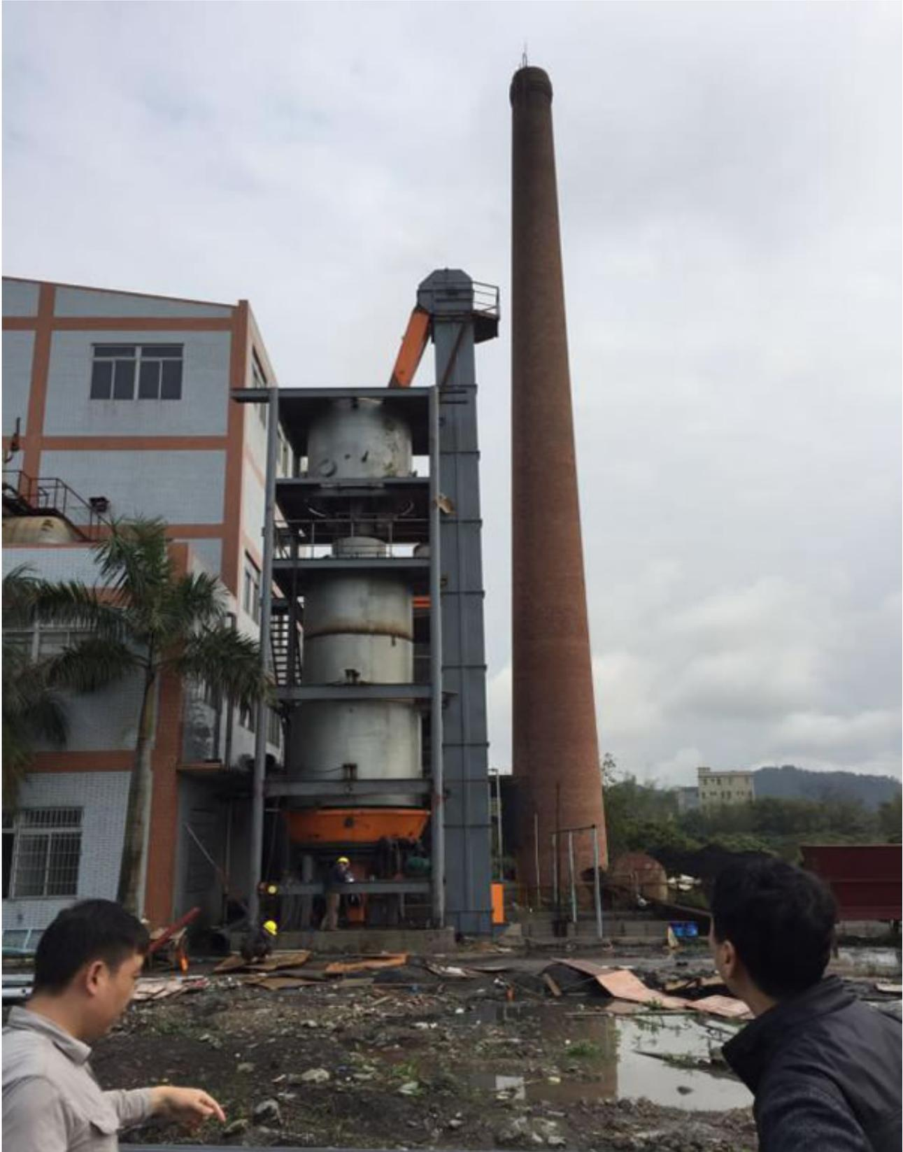
5、10吨气化炉，应用于10吨导热油锅炉
