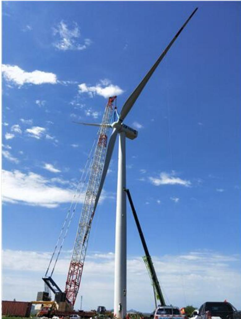
华电莱州薛家项目将安装25台上海电气2MW风电机组。该项目处于山东省莱州市郭家店镇境内，属于莱州湾沿岸丘陵地带，这也给设备运输增加了难度。由于叶片超长运输车辆对于道路的要求比较高，现场人员多次与土建公司看路和测量，确保了设备顺利及时进场。
