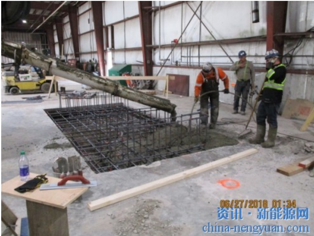
员工在Skeena BioEnergy工厂完成了冷却器基础的第一次混凝土浇筑。
