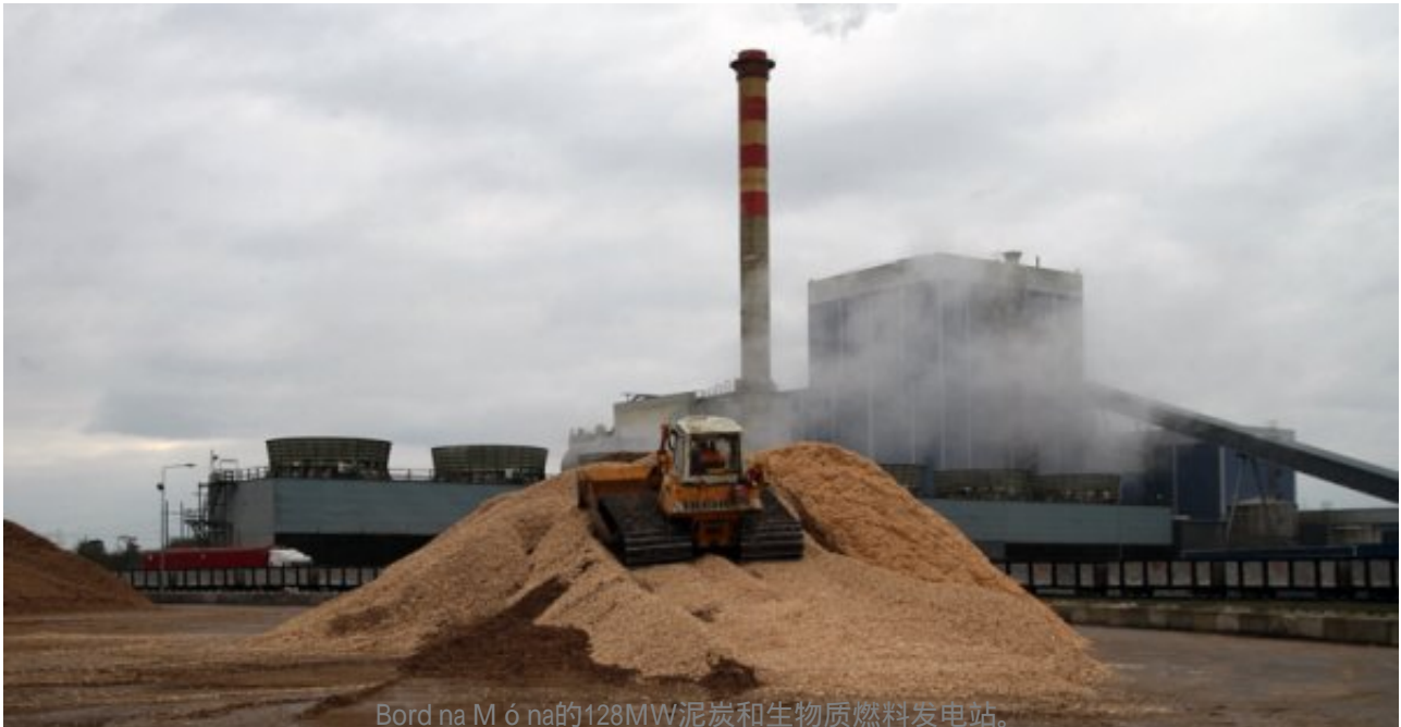
Bord na M ó na的128MW泥炭和生物质燃料发电站。
