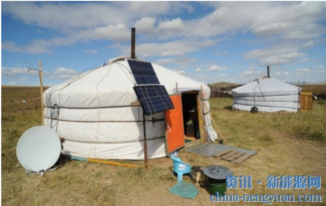
由亚行基金支持的蒙古太阳能分布式发电系统
