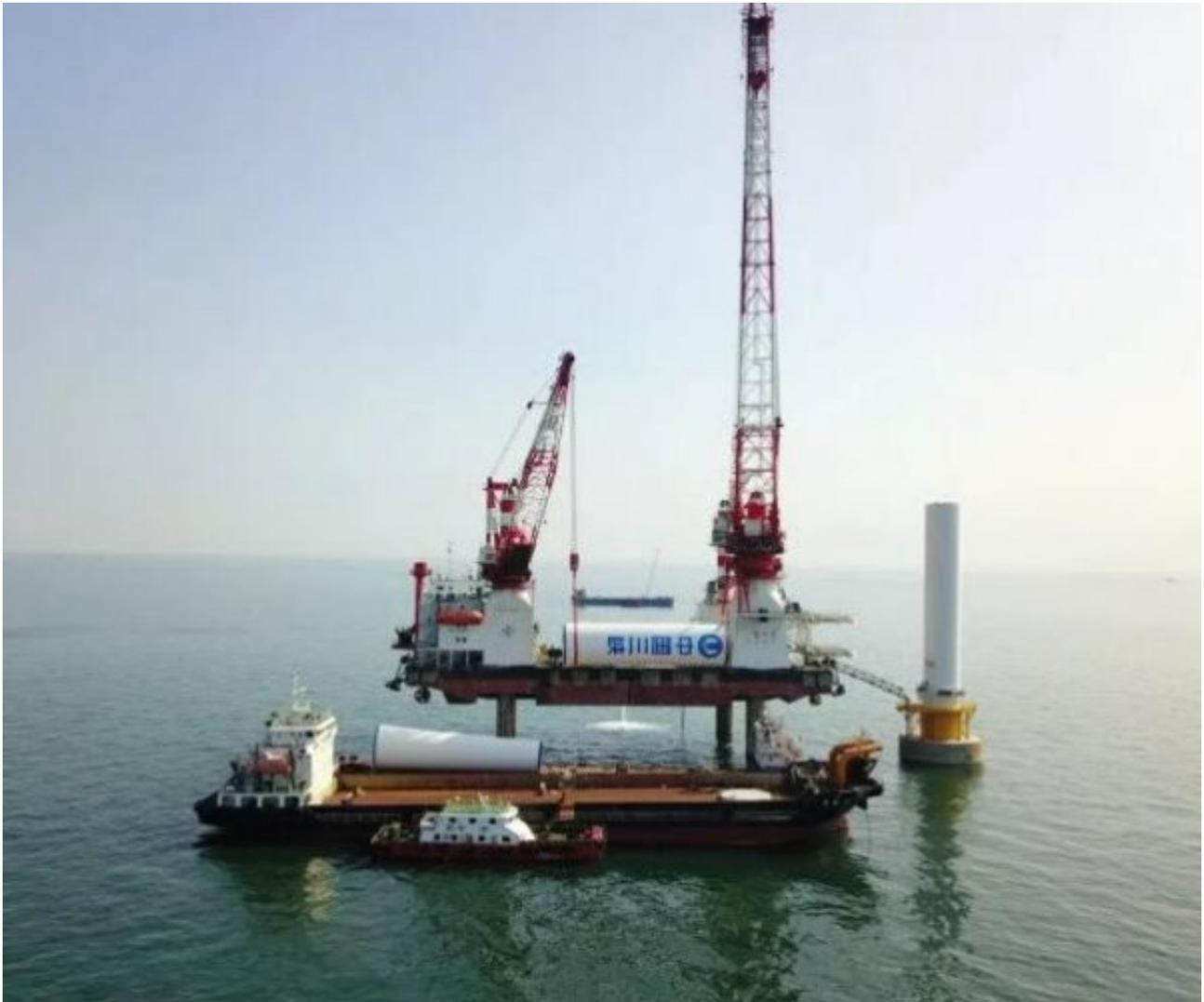
机组型号GW171/6450，机组轮毂中心标高108.5米，叶轮直径达171米，是我国首台低温型、大直径直驱机组。
