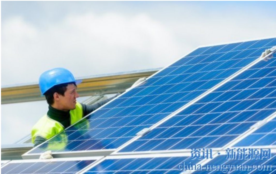
太阳能电池板的安装( www.tplusgroup.ru )
