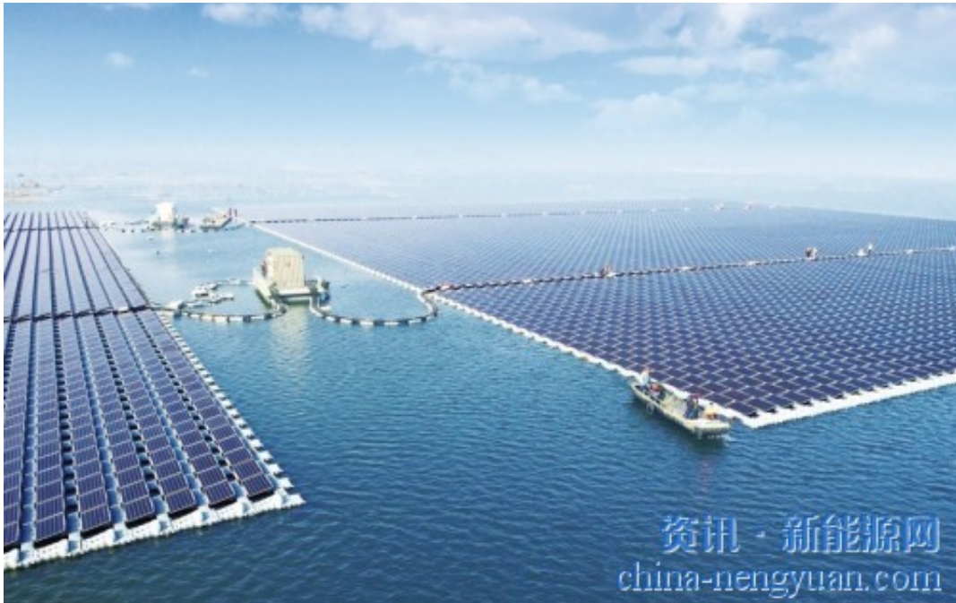
40MW浮动式光伏电站。图片来源：阳光电源有限公司
