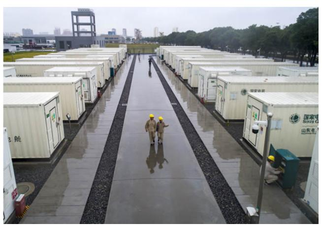
11月7日,技术人员在镇江北山电网储能电站进行巡视。镇江共建造8座储能电站,总功率为10.1万千瓦,总容量20.2万千瓦时,是国内规模最大的电池储能电站项目。今年7月份投运以来,总充电量24627MWh,总放电量22319MWh。汤德宏 黄 海 摄
