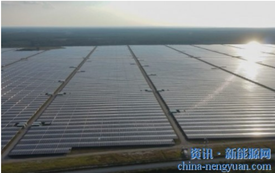
内奥恩的Cestas太阳能公园。照片：Neoen( www.neoen.com )
