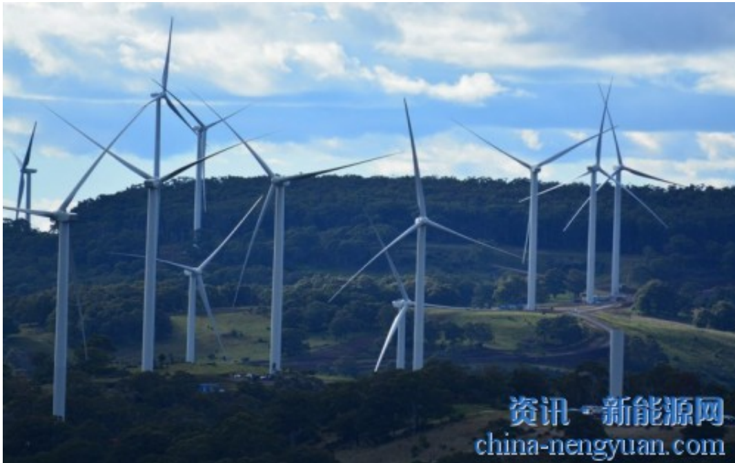
怀特洛克风电场。来源：Windhoist
