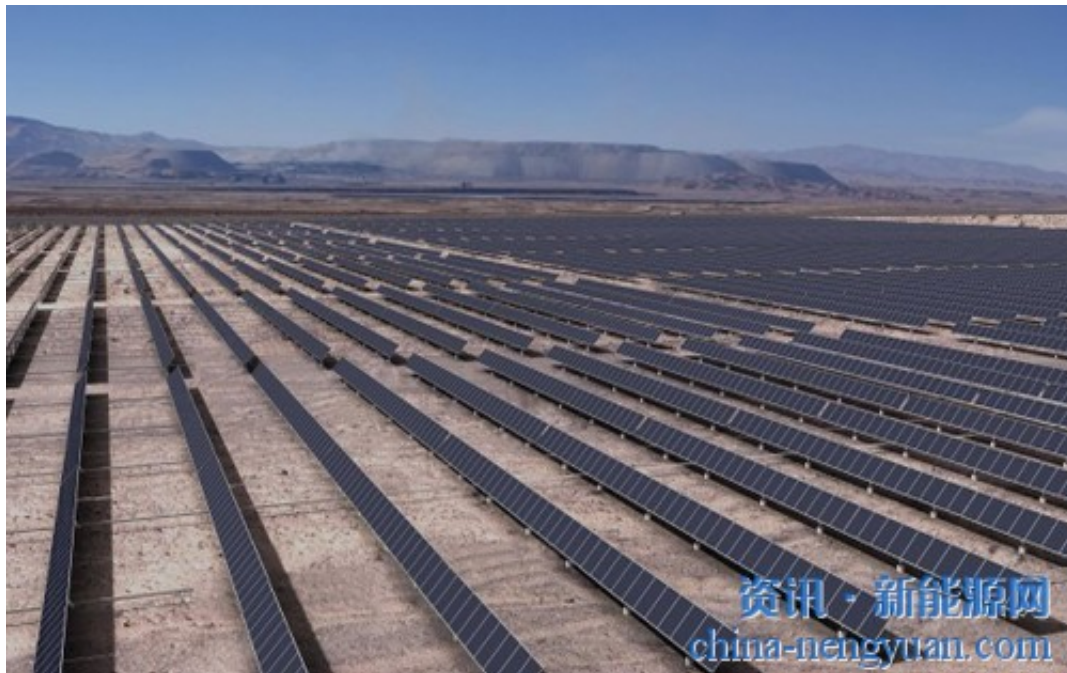
智利45MW光伏电站
