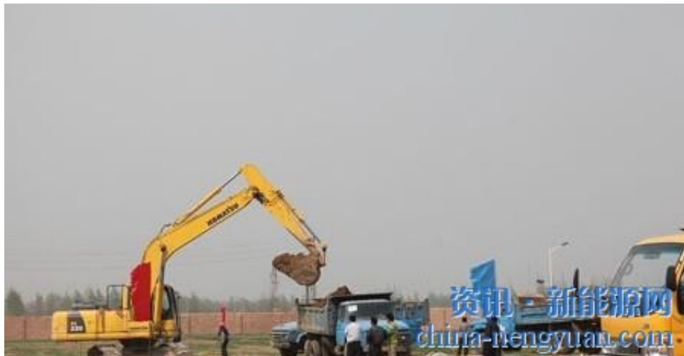
安阳新能源项目工程正在紧张进行中
