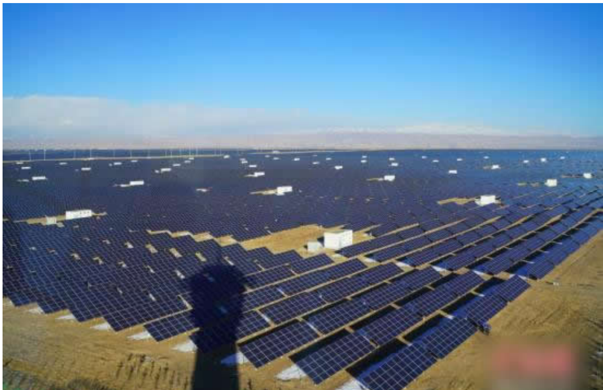
资料图：青海省海南藏族自治州共和县塔拉滩生态光伏发电园区内的太阳能光伏板。中新社记者 张兴龙 摄
