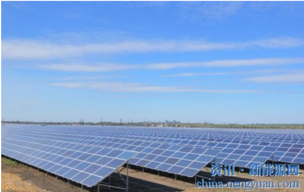
Activ Solar在乌克兰的Dunayskaya太阳能电站。作者：Activ Solar
