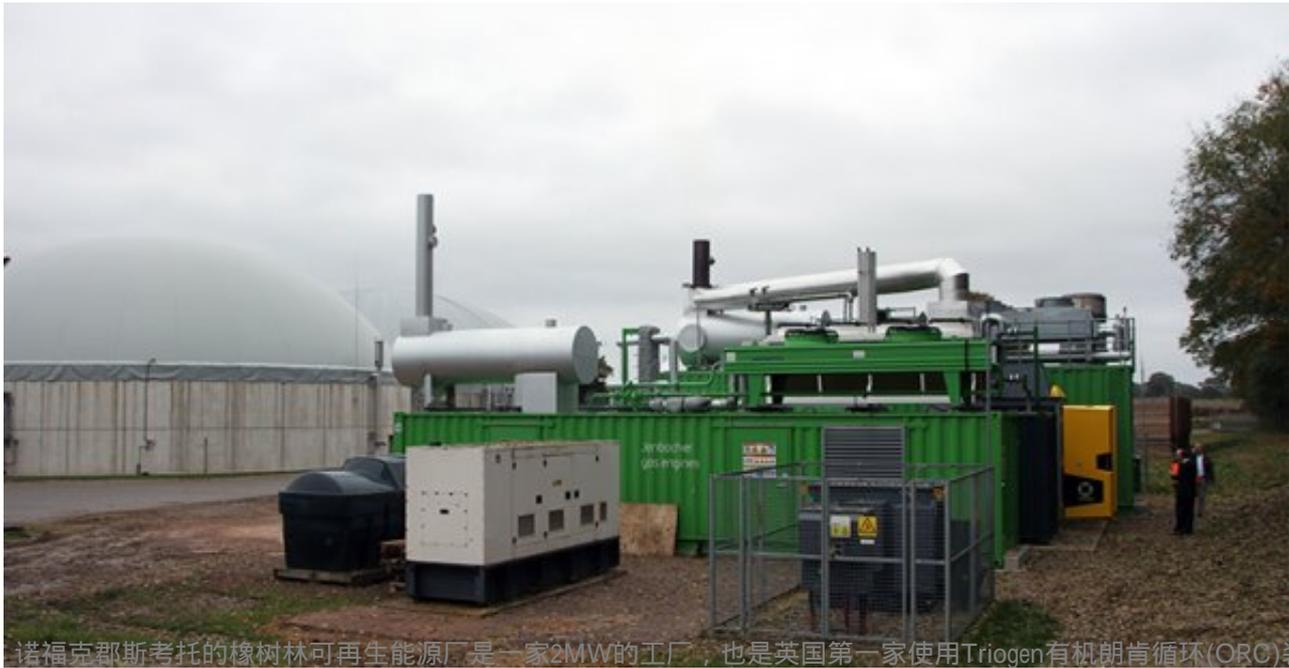
诺福克郡斯考托的橡树林可再生能源厂是一家2MW的工厂，也是英国第一家使用Triogen有机朗肯循环(ORC)装置的工厂，利用天然气发动机的余热发电。
