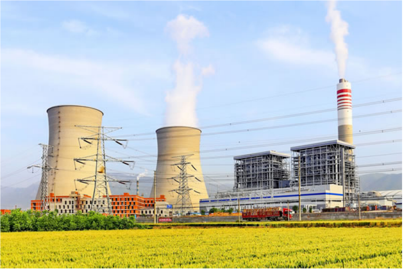
图为沁阳电厂全景
