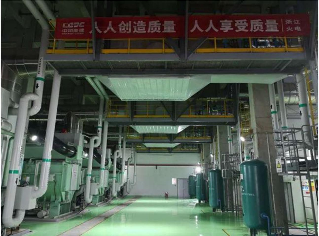
该项目由中国能建华东建投浙江火电承建，是中国联通华东地区目前最大的分布式能源项目，也是浙江省最大的天然气分布式能源项目，装机规模为7台4275千瓦燃气内燃机组。
