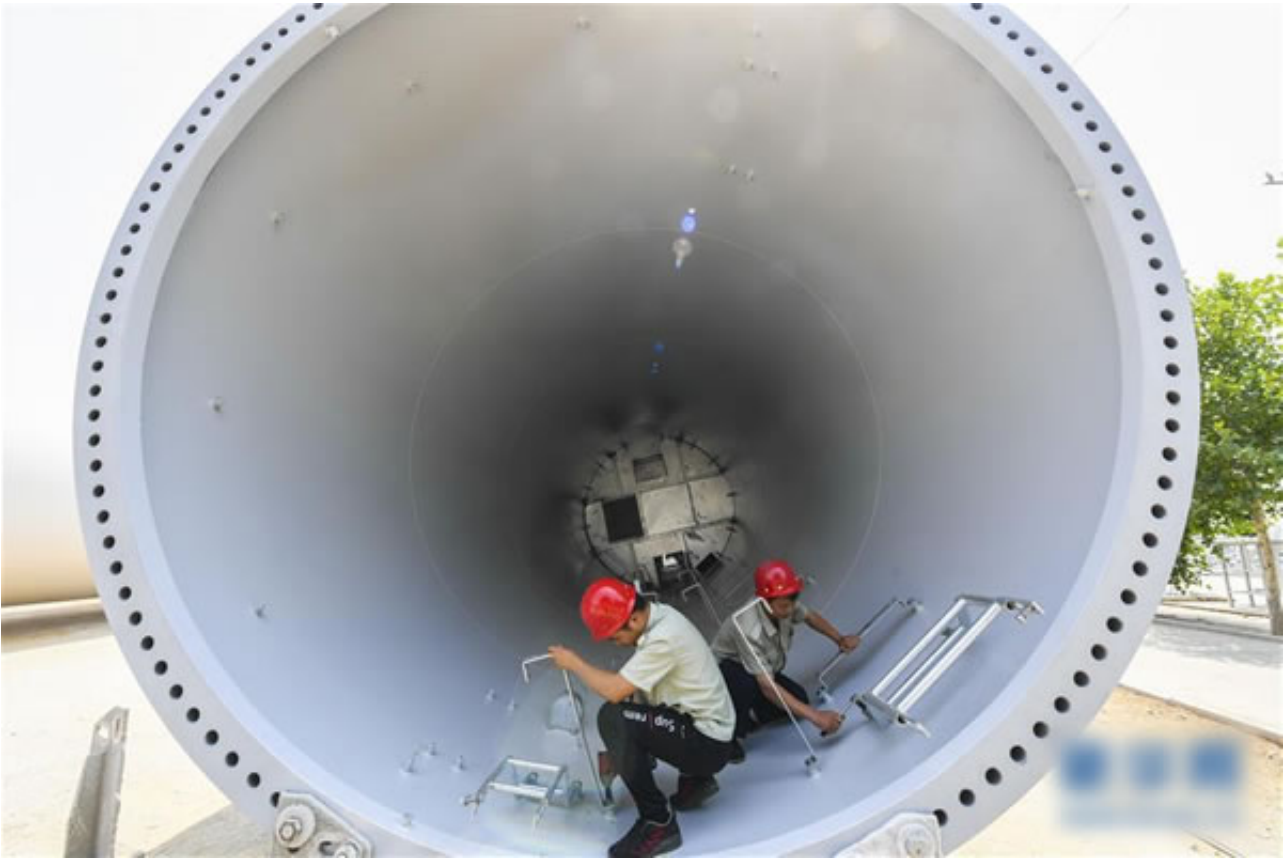
6月18日，河北景县的洁绿重工有限公司工人在风电塔筒内部安装零部件。
