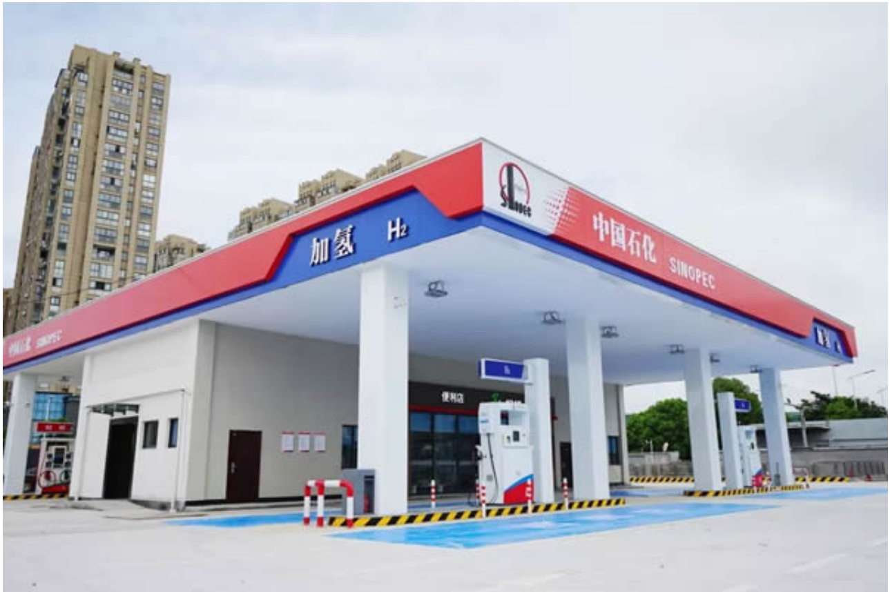
中国石化嘉善善通加油加氢站全景
