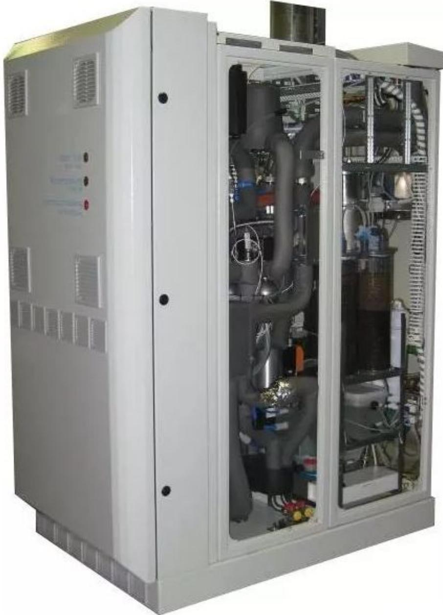
铎德5kW氢能燃料电池分布式能源系统（图源自铎德氢能）
