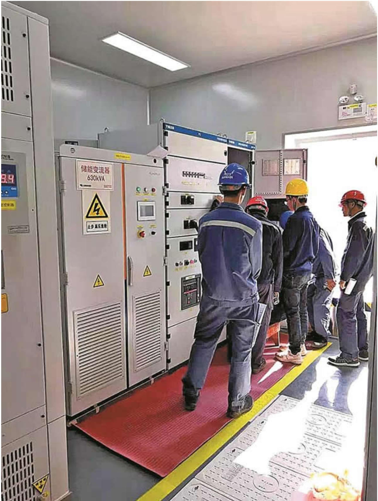
泰昂能源技术工程师现场调试微电网系统。
