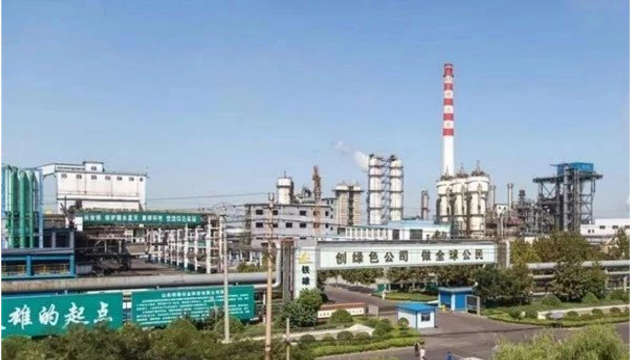
铁雄冶金作为山东省焦化行业支柱性企业，具备实施焦炉煤气制氢的优势条件，目前公司每小时焦炉煤气发生量为140000m<sup>3</sup>/h，副产氢气约77000m<sup>3</sup>/h，采用PSA工艺可得纯度大于99.99%的氢气65000m<sup>3</sup>/h。
