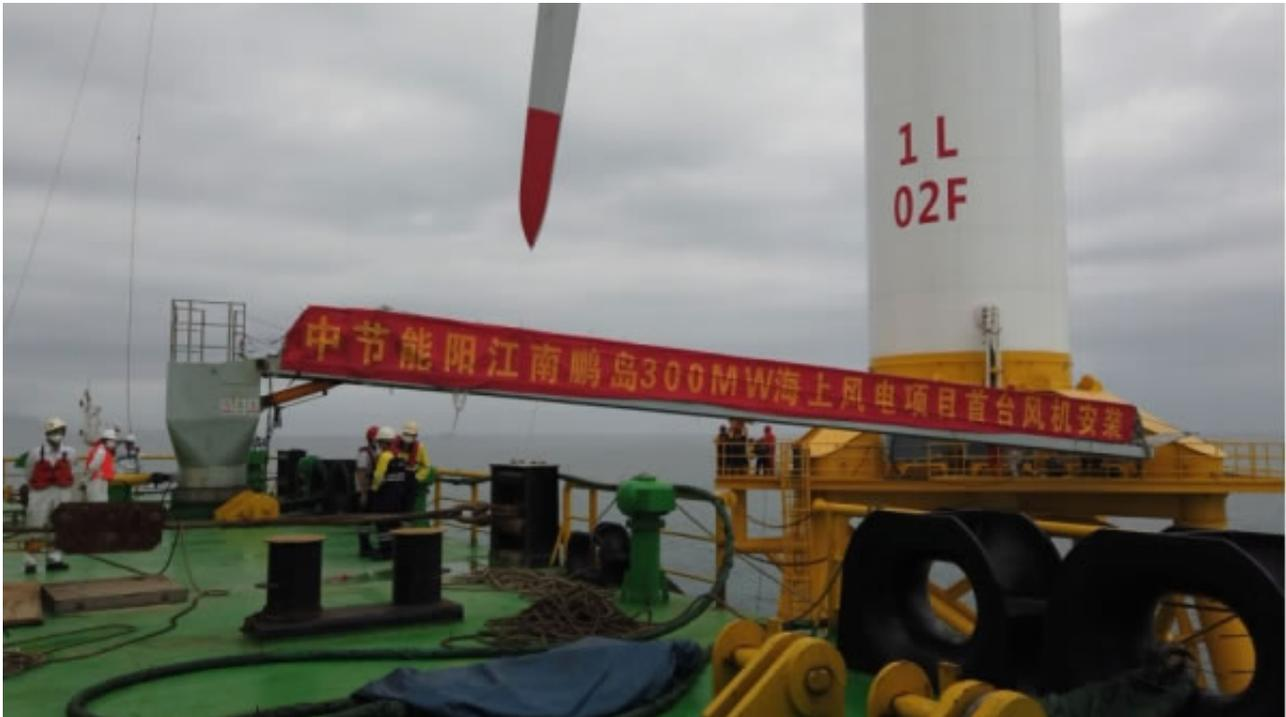
据了解，阳江南鹏岛海上风电项目是中国节能首个海上风电项目和单体最大投资项目，建成投产后年发电上网电量为7.93亿千瓦时，对于促进地方经济绿色发展、拉动地区经济转型升级有着重要意义和极强的示范作用。项目工程规划建设55台5.5MW风机和220kV升压站一座，于2019年5月正式开始海上施工，目前已完成11台风机基础施工，1回220kV海缆敷设，海上升压站基础施工及上部组块陆上建造，陆上集控中心工程主体建设。
