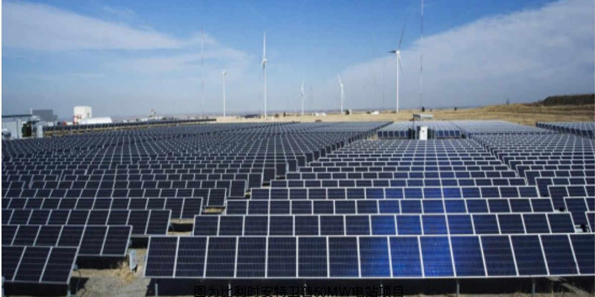
图为比利时安特卫普50MW电站项目
