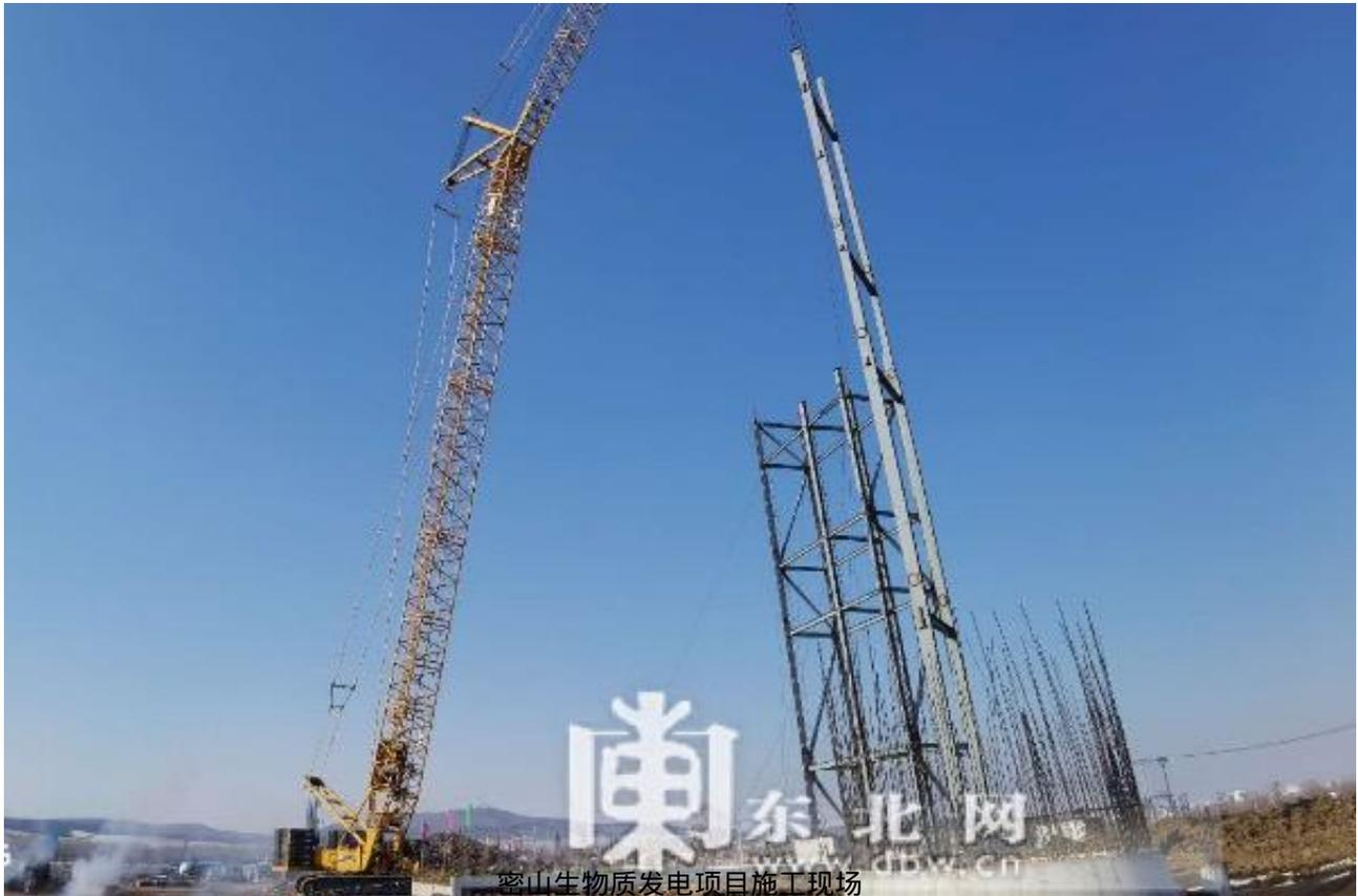
“在去年完成主厂房基础、锅炉基础、综合楼基础、烟囱基础、设备基础的基础上，今年2月27日开复工之后，完成7.3公里接入国家电网线路工程17座基础的开挖和浇筑，完成锅炉钢结构安装三分之一，完成14台套主辅设备的招标采购。项目投产后，预计年消耗15万吨秸秆、10万吨稻壳、玉米芯、木材等边角废料，年发电2.1亿千瓦时、总收入超亿元。”密山辰能生物质发电有限公司副总经理夏志鹏告诉记者。
