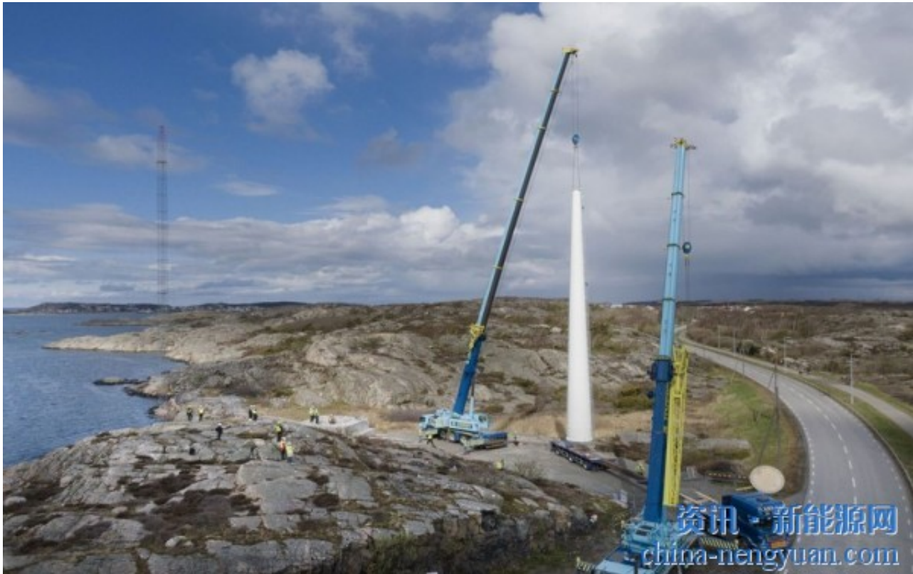
Modvion在瑞典建造的第一座用于风力发电的木质塔筒。
