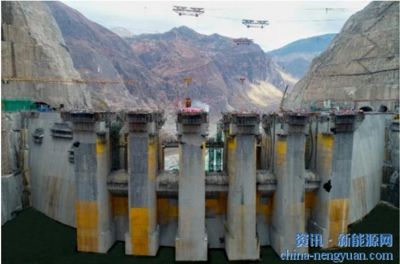
中国三峡集团公司在其推特上表示，中国乌东德水电站的最后一段大坝于5月4日竣工，标志着世界上首座300米低温混凝土拱坝竣工。三峡大坝是中国第四大水坝。乌东德10.2GW项目位于云南省金沙江下游。它将配备12台850MW的Francis发电机。
