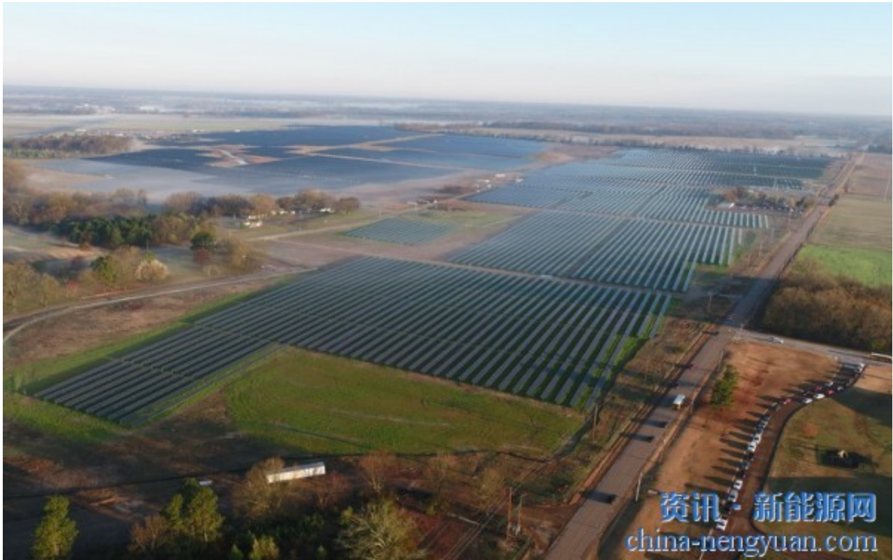
位于田纳西州中南部的太阳能电站
