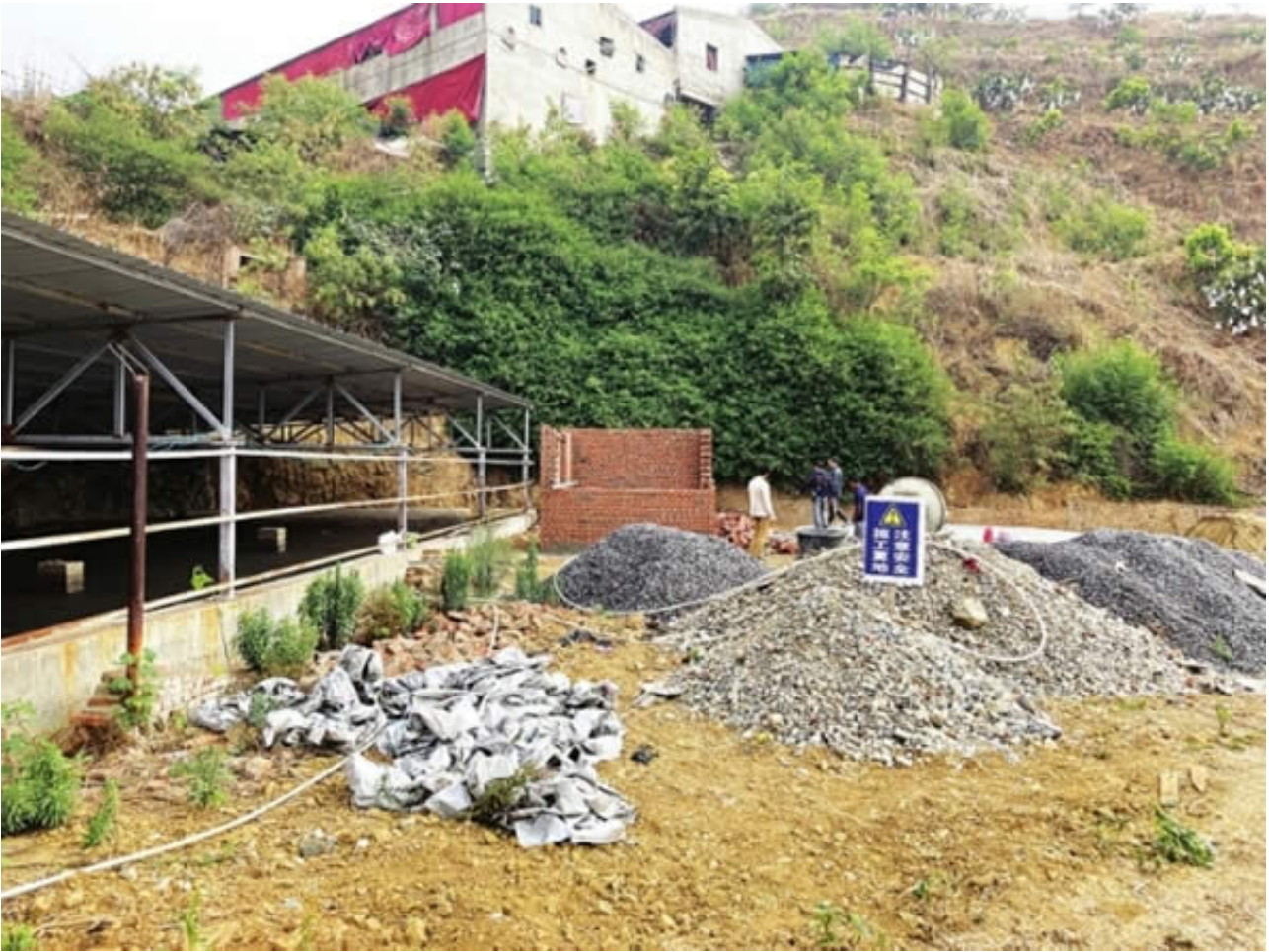
沼气集中供气工程项目建设现场。
